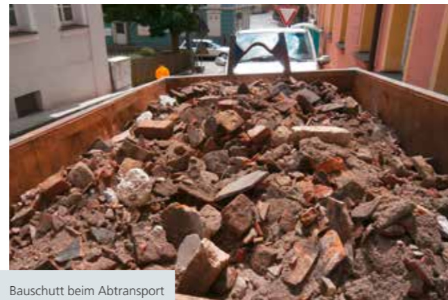
Bauschutt beim Abtransport
